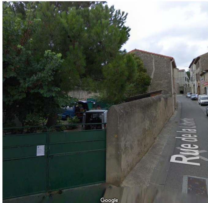
Mur avant intervention
